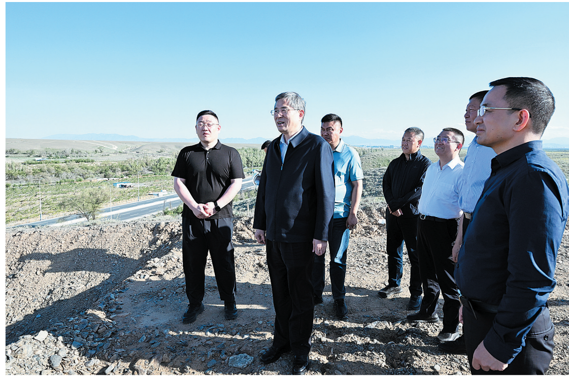
五月十五日，自治区党委副书记、兵团党委书记、政委何忠友到十二师深入调研交通基础设施项目建设工作。这是何忠友在G312线西山新区至乌鲁木齐东二环公路项目施工现场，实地察看项目进度和工程质量情况。 兵团日报全媒体记者张鑫摄
